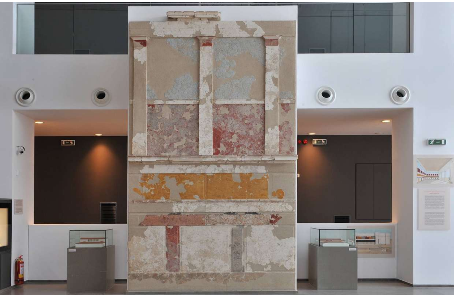
8. Αποκατεστημένη διακόσμηση τοίχου οικίας με έγχρωμα κονιάματα (Μουσείο Πέλλας).
