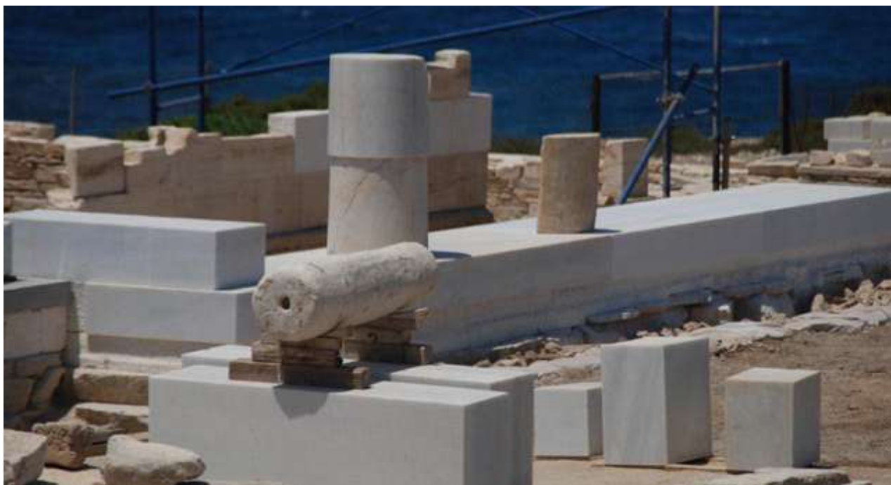
Αναστηλωτικές εργασίες στο Δεσποτικό Αντιπάρου (φωτ. ΥΠΠΟΑ).
