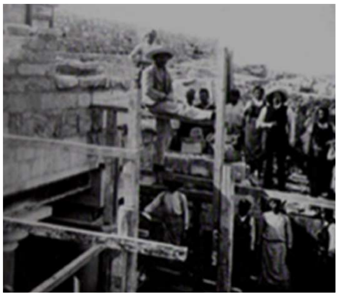
Ανάκτορο Κνωσού. Αναστήλωση Κλιμακοστάσιου.
