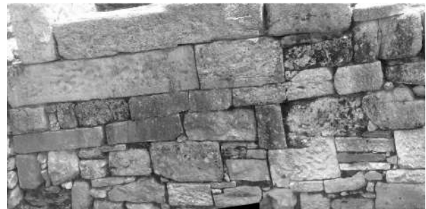
10. Εξωτερική όψη του δυτικού σκέλους του αψιδωτού κτίσματος.
