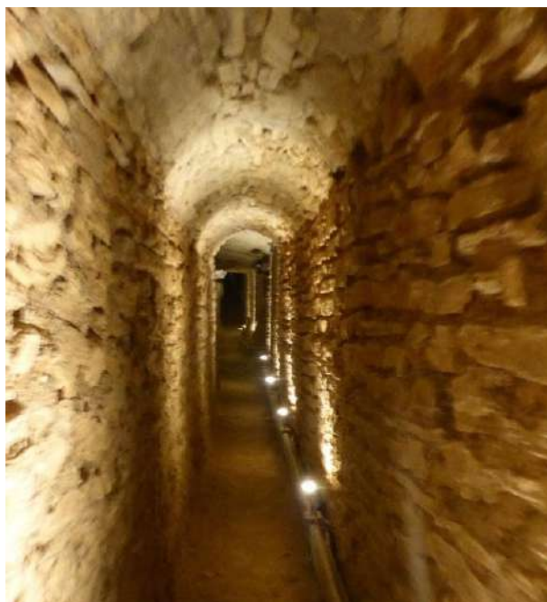
Ευπαλίνειο Όρυγμα. Άποψη της σήραγγας (φωτ. ΥΠΠΟΑ).
