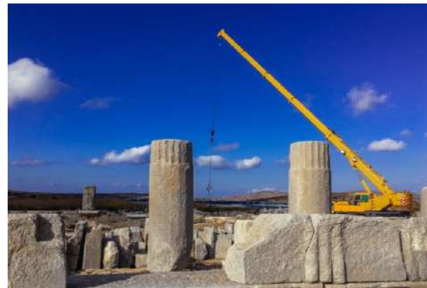
Ανάσωση και ταξινόμηση αρχιτεκτονικών μελών με γερανό, Οκτώβριος 2017 (φωτ. Α. Ευσταθόπουλος).
