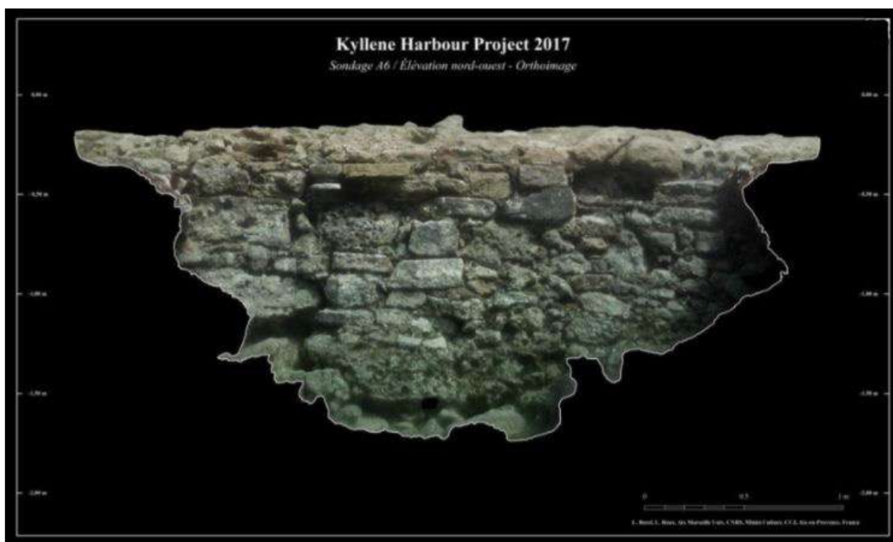
Κυλλήνη –Γλαρέντζα. Φωτογραμμετρικές αποτυπώσεις λιμενικών κατασκευών (φωτ. ΥΠΠΟΑ).
