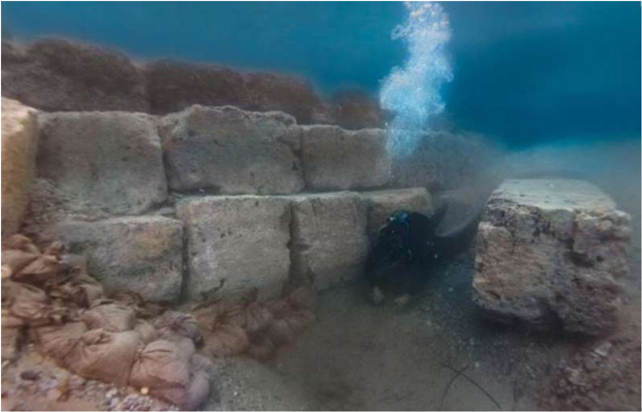
Ο Μόλος 1 (L-M1) του λιμένα του Λεχαίου είναι κατασκευασμένος από μεγάλους δόμους διαστάσεων (φωτ. ΥΠΠΟΑ).
