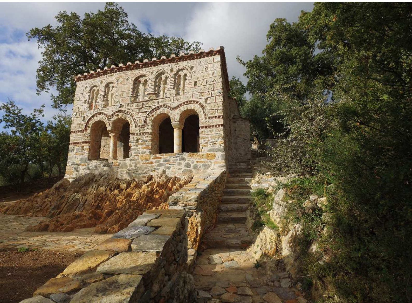
Ο ναός του Άι Στράτηγου μετά την ολοκλήρωση των εργασιών αποκατάστασης (© ΕΦΑ Μεσσηνίας).
