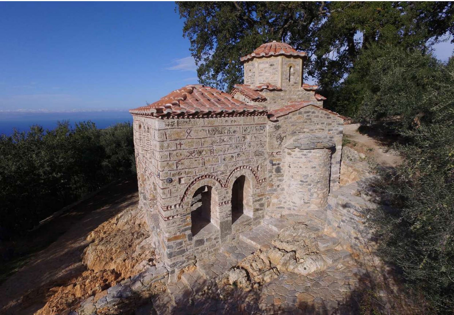
Ο ναός του Άι Στράτηγου μετά την ολοκλήρωση των εργασιών (© ΕΦΑ Μεσσηνίας).
