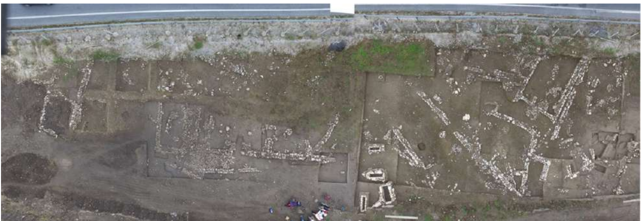
Γενική άποψη της ανασκαφής στην «Ασβεσταριά» Πετρωτού Τρικάλων (φωτ. ΕΦΑ Καρδίτσας).
