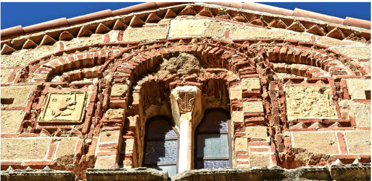
10. Λεπτομέρεια από τη νότια όψη του καθολικού της Μονής Περιβλέπτου. Στις πλευρές του ανοίγματος λιθανάγλυφα με λέοντα και αποξεσμένο, ενώ ένα τρίτο βρίσκεται πάνω από το άνοιγμα (φωτ.: Α. Τάντσης).
