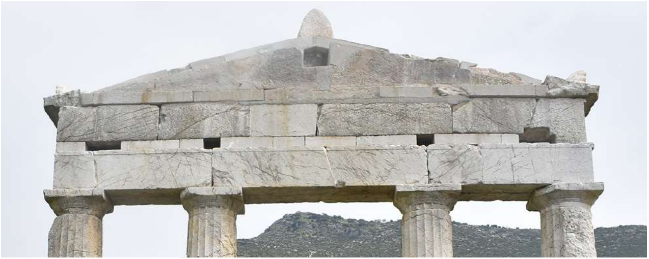
5. Άποψη της πίσω νότιας πλευρά του Πρόπυλου. Διακρίνονται οι εγχοπές στα αντιθήματα των επιστυλίων και του αετώματος.
