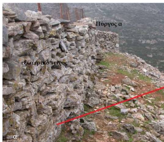
17α-β. Το εξωτερικό μυκηναϊκό τείχος (Φάση III) και ο Πύργος α (Φάση II) πριν και μετά την ανασκαφή (λήψεις/αρχείο Χ. Α. Τελεβάντου).
