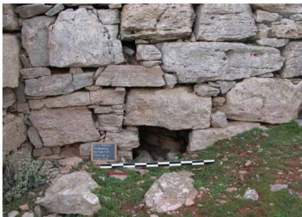
20. Υπόνομος νότια του Πύργου α (λήψη/αρχείο Χ. Α. Τελεβάντου).
