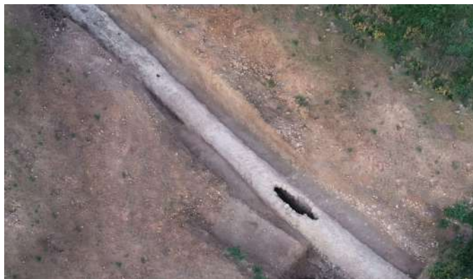
1. Τμήμα του Αδριάνειου υδραγωγείου.
