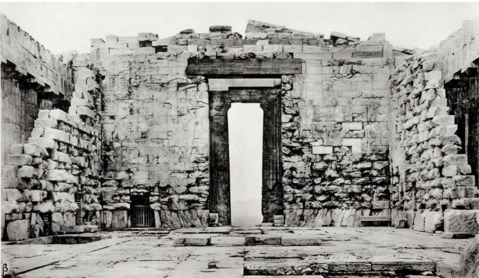
23. Μετά την ολοκλήρωση του υπερθύρου από οπλισμένο σκυρόδεμα στην Δυτική Θύρα του Παρθενώνα (1926).
