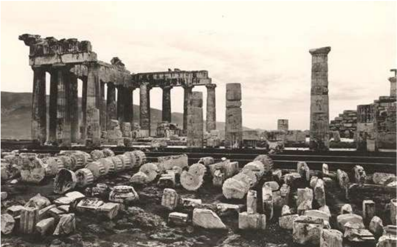
17. Ανατολικό τμήμα της Βόρειας Κιονοστοιχίας, όπου φαίνονται οι σπόνδυλοι των κιόνων διαταγμένοι προς αναστήλωση.
